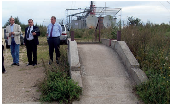
Bestehende Bahntrasse in Goldap / POL Existing track in Goldap / POL
