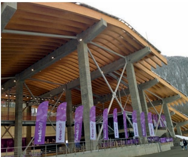
Gigantische Dachkonstruktionen aus Holz Gigantic roof constructions made of wood
