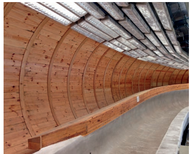
Auch innenseitig der Bahn: Massive Kurvenauskleidungen aus Holz Also inside the track: Massive curve coatings made of wood
