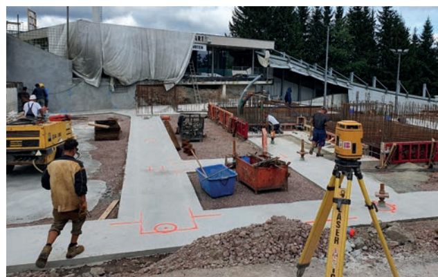
Umbau und Erweiterung Herrenstart Reconstruction and expansion men's start
