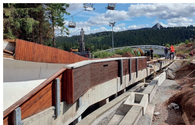
Umbau der Kurven 11 und 12 Reconstruction curves 11 and 12
