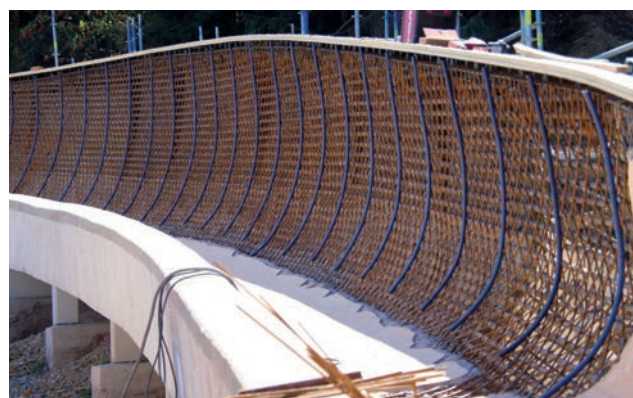
Umbau der Kurve 10 Reconstruction curve 10
