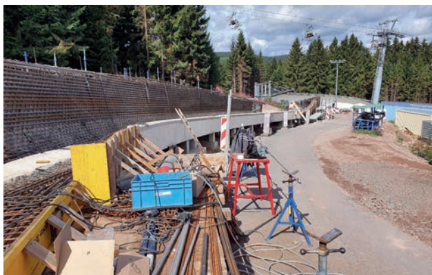
Umbau der Kurve 9 Reconstruction curve 9
